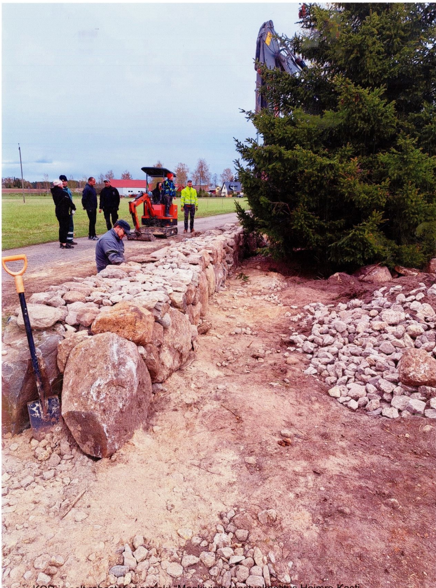
KOP-i poolt rahastatud projekt "Maakiviäia taastuskoolitus Haimre-Kasti kogukonnale". Õppepäev 29.aprillil 2023.a. endise Järgküla maantee ääres.
