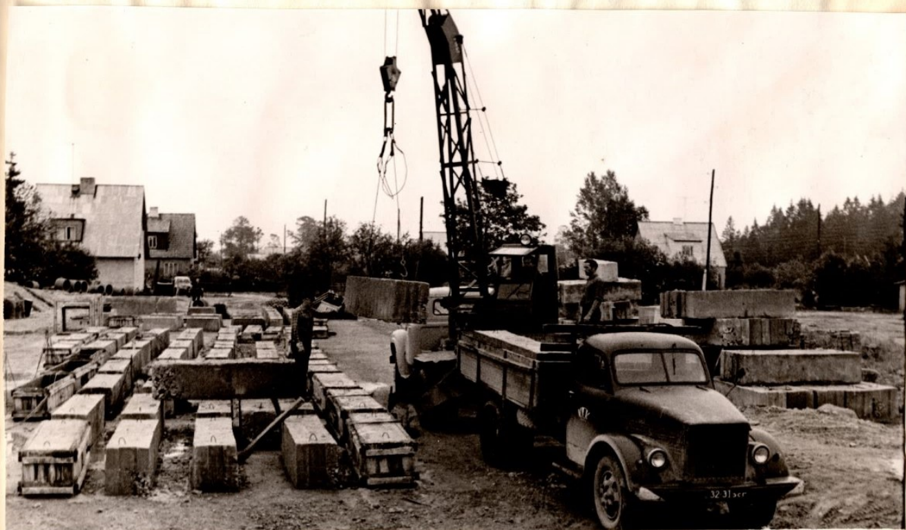
Reinold Valtin testab autole (juht Valdek Hertvig) plokkide Marjamaa betoonitehni põlvkonnilt. Need lähevad "Vabaduse" kolhoosi karjalauda vundamendi jaoks.
