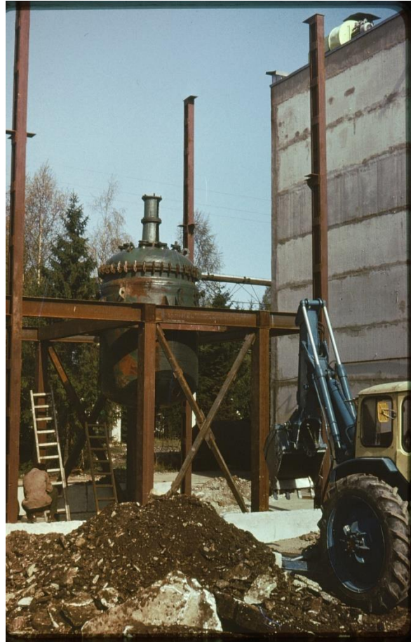
Rapla KEK-i Raikküla tootmisbaasis valmistati ehituste tarbeks vajalike liime. Pildil uue liimi keetmise anuma montaaž.
