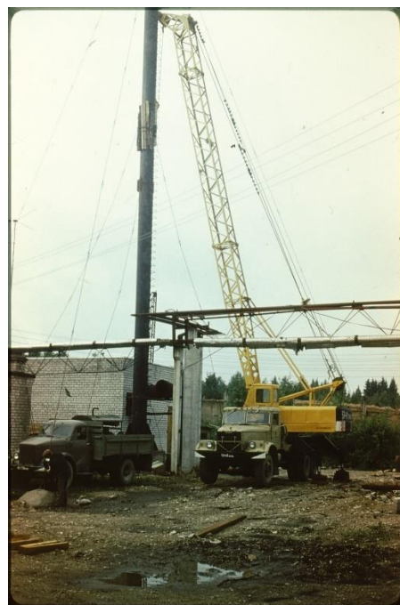
Rapla KEK-i Raikküla tootmisbaasi uue katlamaja korstna püstitamine 1983. aastal.
